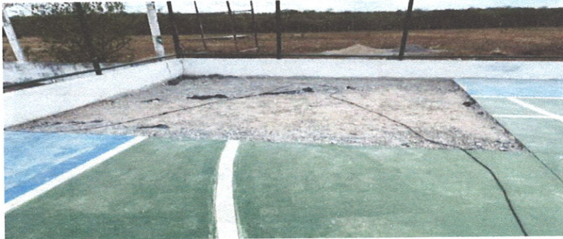
RECUPERAÇÃO DE PISO DA QUADRA
